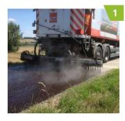
Nach sorgfältigem Reinigen der Straße wird das Bindemittel nach Verlegerichtlinie des Vlies-Herstellers aufgebracht.
