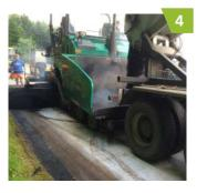
Abschließend wird die Vlies-Schicht mit Heißasphalt überbaut.
