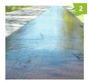
dem Aufbringen des Bindemittels muss die Brechzeit (Trocknungszeit) abgewartet werden.
