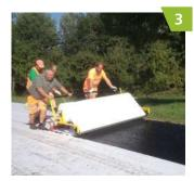
Im Anschluss wird das Vlies auf die Bitumenschicht faltenfrei appliziert. Speziell in Kurvenbereichen muss bei Bedarf abgestreut werden.
