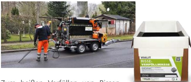
Zum heißen Verfüllen von Rissen, Fugen und Nähten in Asphalt und Beton. Die Verarbeitung erfolgt mit einem speziellen Heißvergusskocher bei einer Temperatur von ca. 180 °C.
