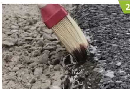
**VIAPLAST HV** mit einer Bürste bzw. einem Pinsel auf die Asphaltnaht auftragen.
