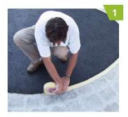
Die zu versiegelnde Fläche gründlich reinigen und mit einem geeigneten Klebeband abkleben.
