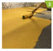
Auftrag portionsweise, je nach Rautiefe des Untergrundes. mittels Gummischieber\* oder Lammfellroller\*.
