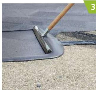
Anschließend mit Gummischieber\* gleichmäßig verteilen ...
