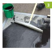
Das abgemischte Produkt portionsweise auf die Unterlage aufbringen und mittels Gummischieber\* verteilen.
