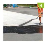
Satt mit geeignetem Splittmaterial (ca. 6 – 8 kg/m²) abstreuen und frühestens nach Ablauf der Trocknungszeit abkehren. Abschließend mit **STRADAKOL**\* farbig versiegeln.
