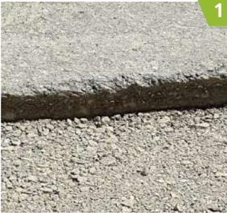
Flankenflächen säubern und gegebenenfalls mit geeignetem Primer vorbehandeln. Fugenband mit der Trennpapierseite nach oben entlang der Kante auslegen.
