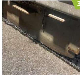
Anschließend kann das Heißmischgut händisch oder per Fertiger eingebaut und gewalzt werden, ...
