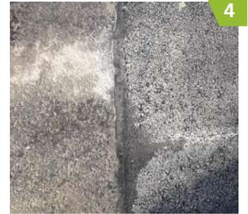
... wodurch sich das Bitumenband mit beiden Bauteilen verbindet und eine flexible Naht, einen flexiblen Anschluss herstellt.
