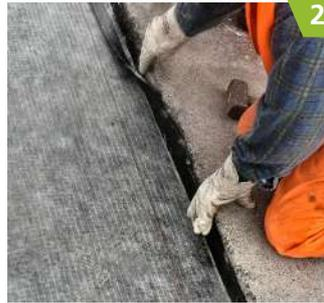
Trennpapier entfernen und das FUGENBAND SK an die vorbereitete Flankenfläche fest andrücken. FUGENBAND SPEZIAL muss vorab mittels z. B. Gasbrenner einseitig angeschmolzen werden.
