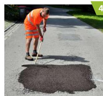
Das eingebaute Mischgut ist abhängig von Witterung und Einbaustärke nach ca. einer halben Stunde befahrbar.
