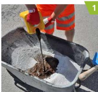
Der Sand wird in einem Mischbehälter vorgelegt und anschließend die Bitumenemulsion zugegeben.
